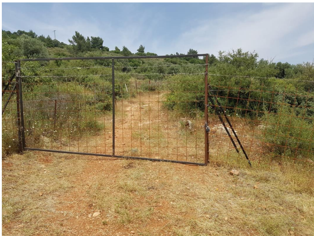
איור 3 – שער בגדר לכיוון פרוד, שמאפשר גירוש חזירים במידה וחדרו ליישוב. השער נבנה באותו מפרט וגובה של הגדר.
