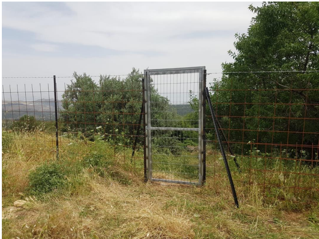
איור 4 – מעבר הולכי רגל (פשפש) שהוקם בגדר ההיקפית לטובת מטיילים, ולמנוע כניסת חזירים.
